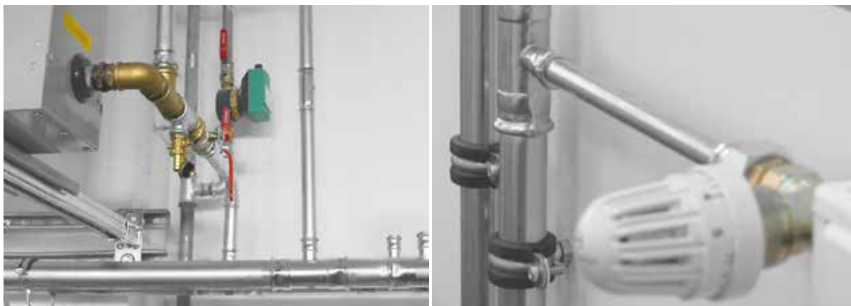
Näited süsteemi KAN-therm Steel paigaldistest
