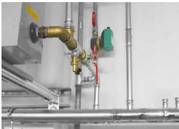
Näited süsteemi KAN-therm Steel paigaldistest
