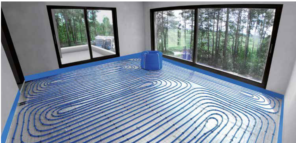
Joon. 3. Ühepereelamu põrandaküttepaigaldis, milles kasutatakse bluePERT torusid ja süsteemi KAN-therm Tacker.
