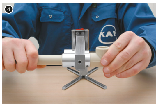
4. Toru ja liitmiku kuumutamine
