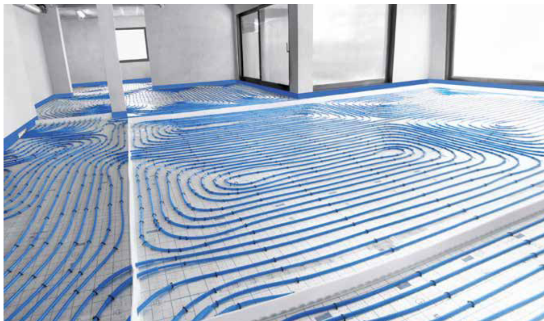
Joon. 24. Põrandaküttesüsteem KAN-therm Tacker
