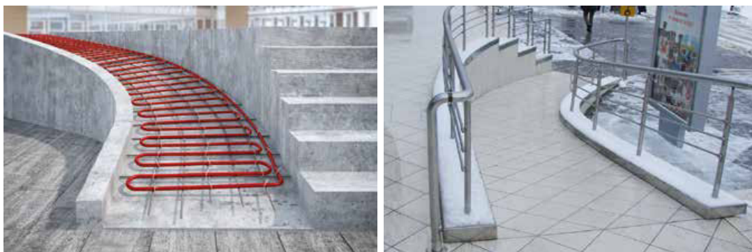
Joon. 35. KAN-therm välispindade kütte - tööde ajal ja pärast tööde lõpetamist
