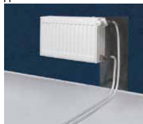
Seinaühendus, kus kasutatakse ülemutriga press-siirdmikke
