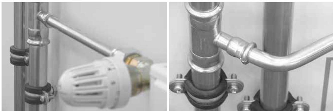
Radiaatoriühendus (pealevoolutoru ja tagasivoolutoru) süsteemis KAN-therm Steel
