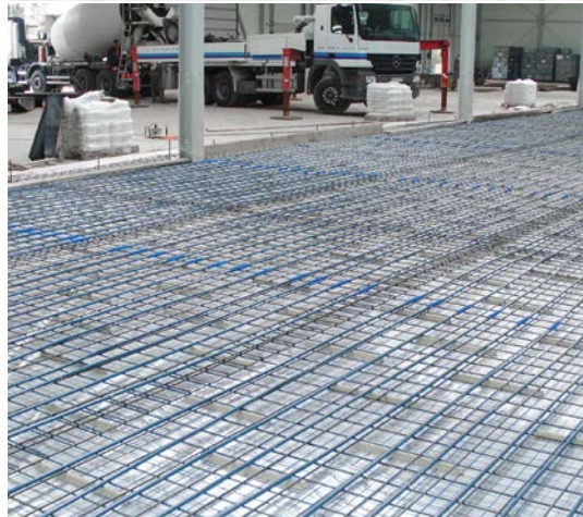
Joon. 4. PE-RT Blue Floor torusid ja süsteemi KAN-therm NET kasutatav põrandaküttesüsteem tööstushoones.
