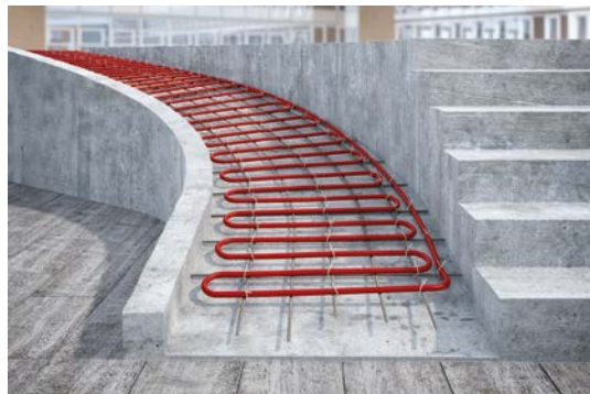
Joon. 41. KAN-thermvälispindade küte - tööde ajal ja pärast tööde lõpetamist
