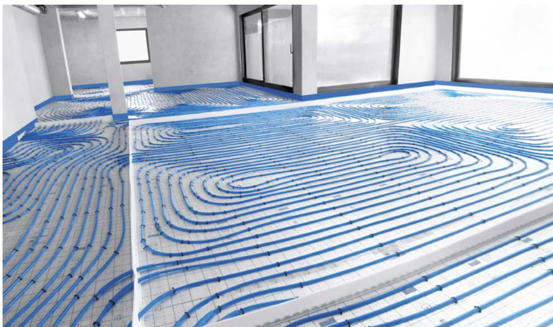
Joon. 24. Põrandaküttesüsteem KAN-therm Tacker
