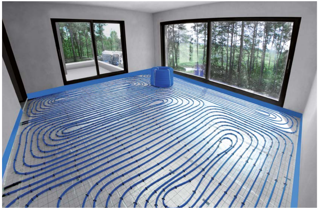
Joon. 3. PE-RT Blue Floor torusid ja süsteemi KAN-therm Tacker kasutatav põrandaküttesüsteem ühepereelamus.
